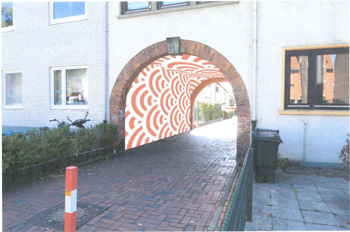
Ansicht von der Gröpelinger Heerstraße aus
