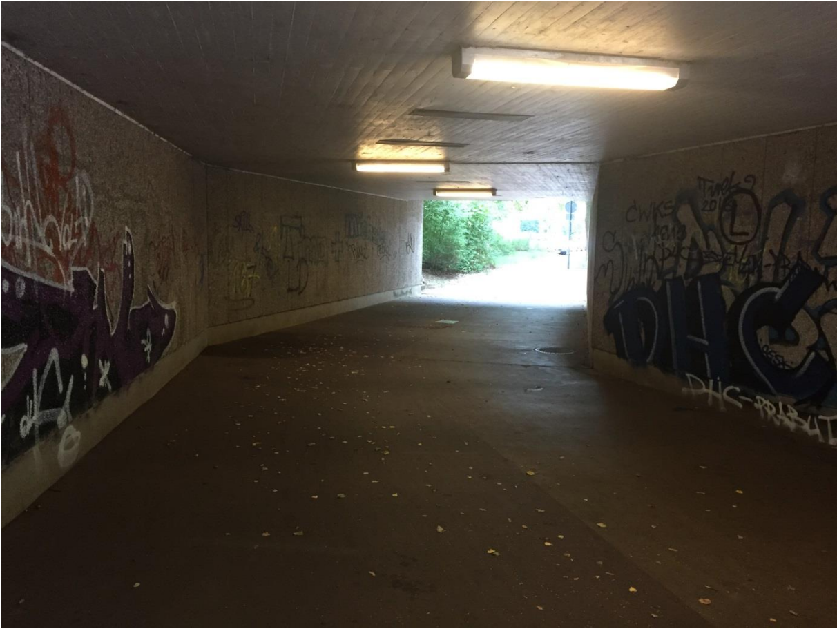
Burgdamm: Tunnel Upsalastr., Marßeler Feld
